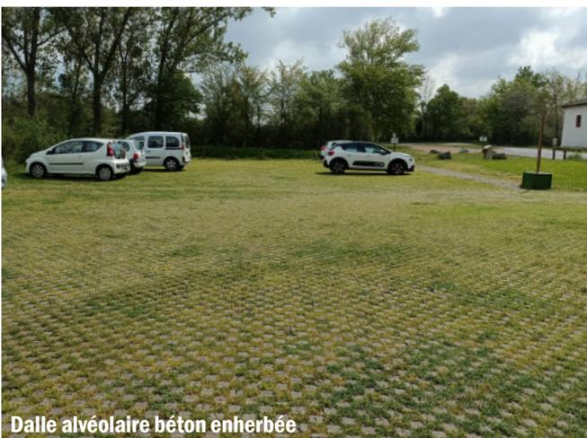
Dalle alvéolaire béton enherbée
