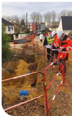
Travaux de voirie.
